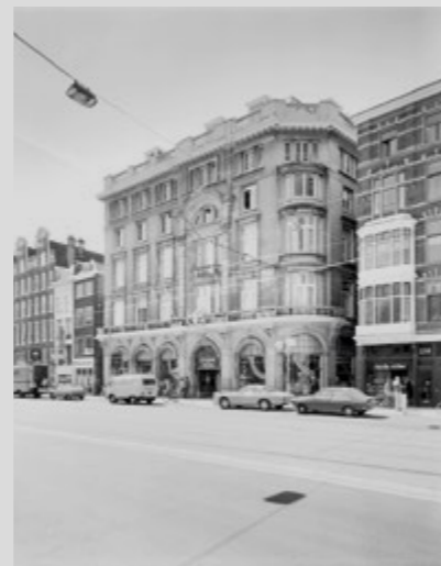
Kalverstraat/Olieslagerssteeg/Rokin, Amsterdam: Maison de Bonneterie (1909)
